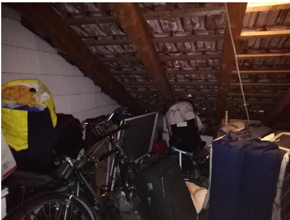
Foto n 27 soffitta sottotetto
